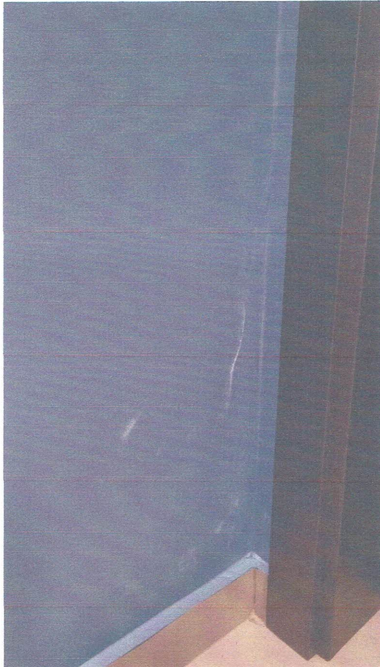
Figura 14 - Eflorescência e bolhas na pintura, exatamente no nível da entrada de água.
