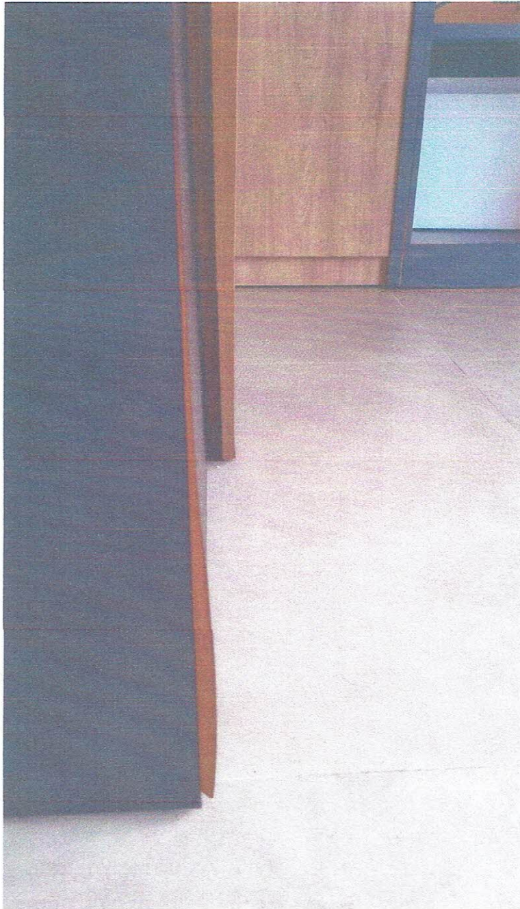
Figura 5 - Estufamento, descolamento, empenamento e presença de mofo na estrutura do móvel.
