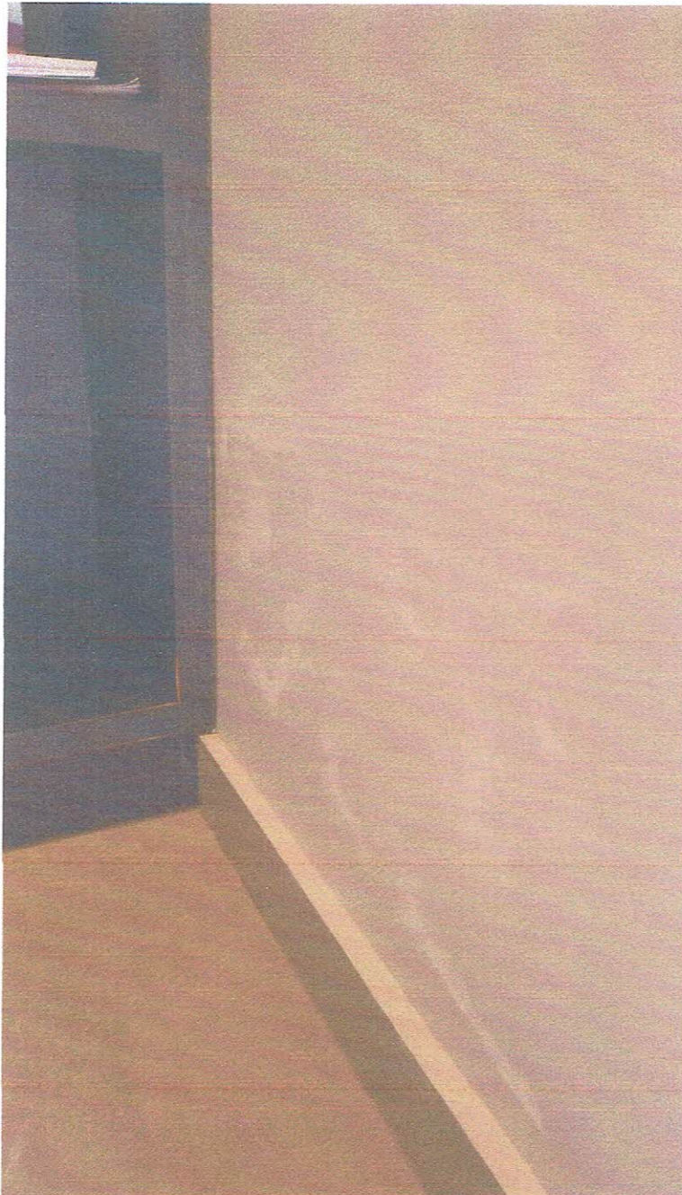
Figura 7 - Eflorescência na parede, exatamente no nível da entrada de água.
