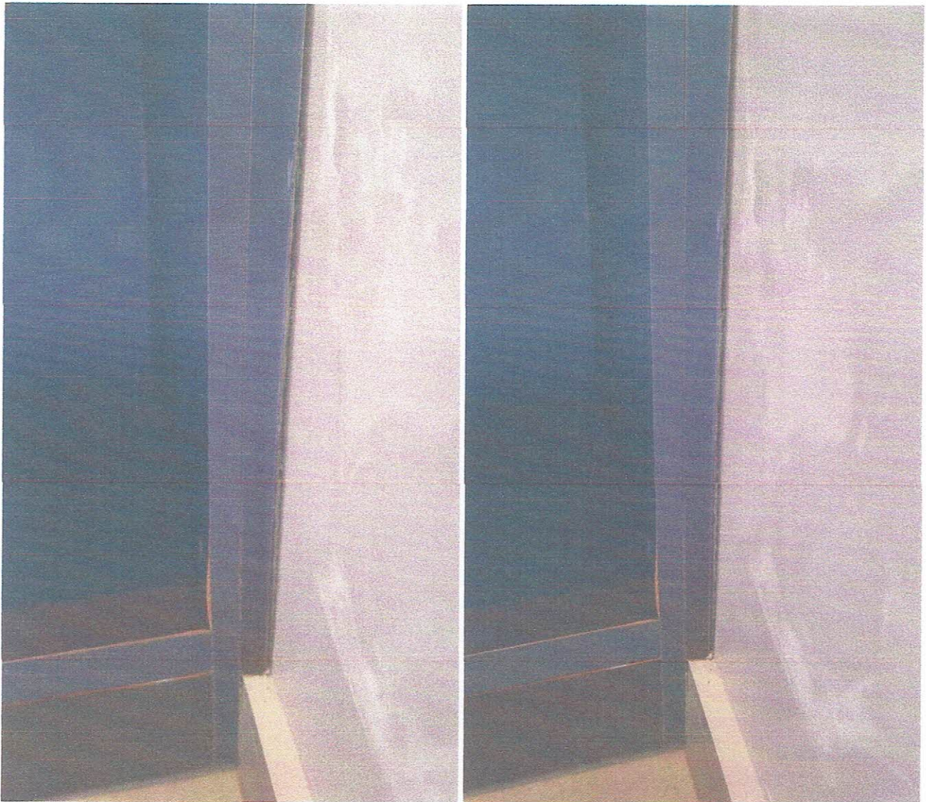
Figura 8 - Estufamento, descolamento, empenamento e presença de mofo na estrutura do móvel.
