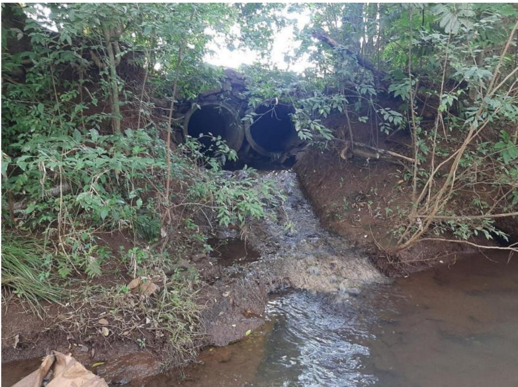
*Figura 86 – erosão e desbarrancamento entre os rios Sarandi e Lambari*
