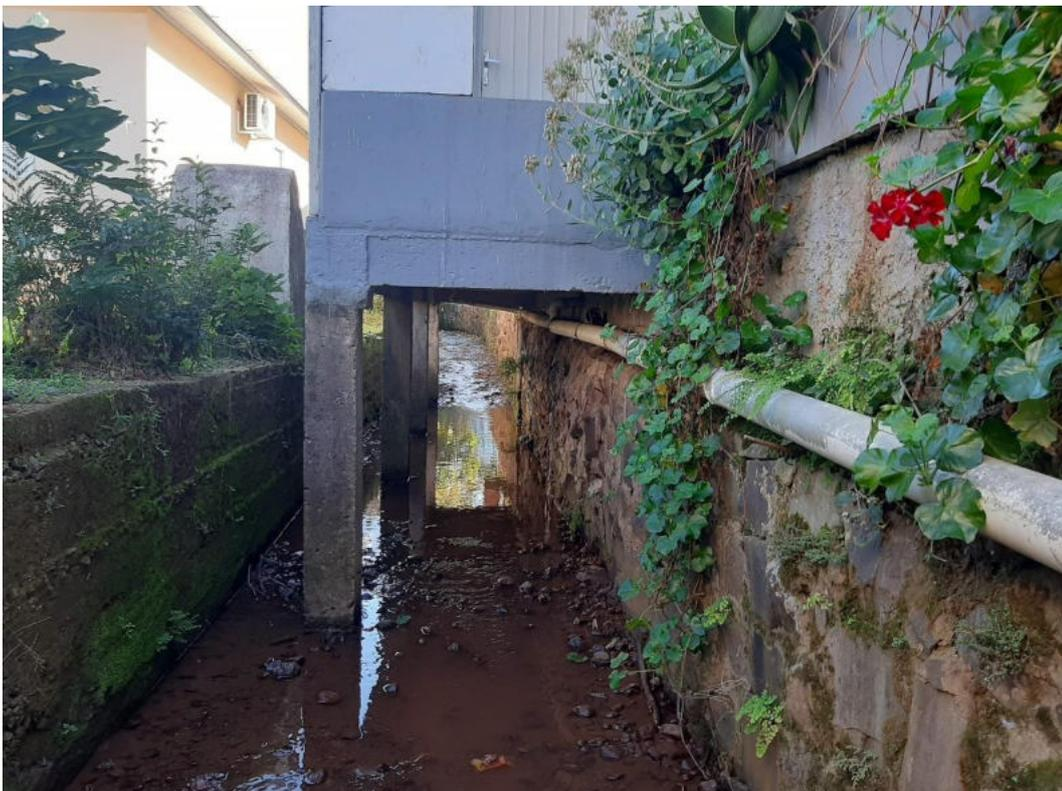
*Figura 16 – Leito da sanga canalizado – vista de jusante do início do trecho canalizado*
