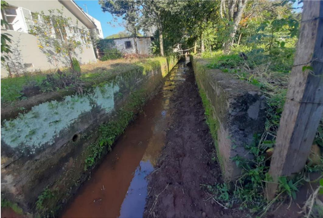
*Figura 30 – Assoreamento próximo ao final da porção aberta do segmento*
