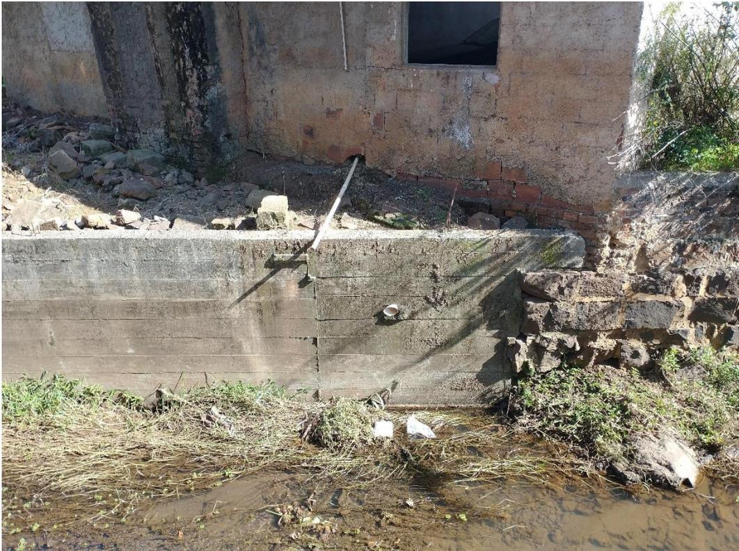
*Figura 32 – Edificação na margem do Arroio Lambari com lançamento de efluente doméstico*
