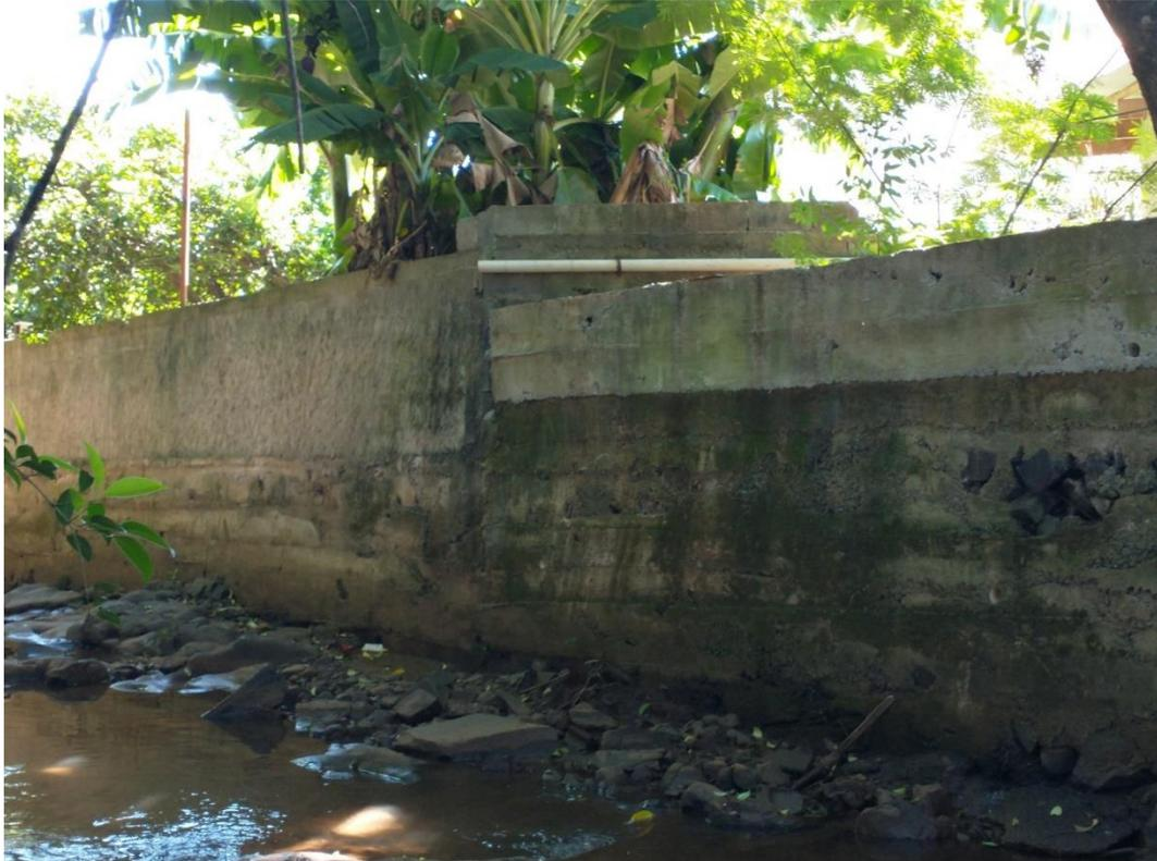
Nesse ponto, foi possível identificar tubulações de drenagem de águas pluviais, dos terrenos bem como de calhas, (Figura 23) sendo que é possível diferenciar tubulações de águas pluviais e de esgoto (tanto sanitário, quanto de pias e maquinas de lavar) em função das marcas que os efluentes deixam no muro ao escoar.
