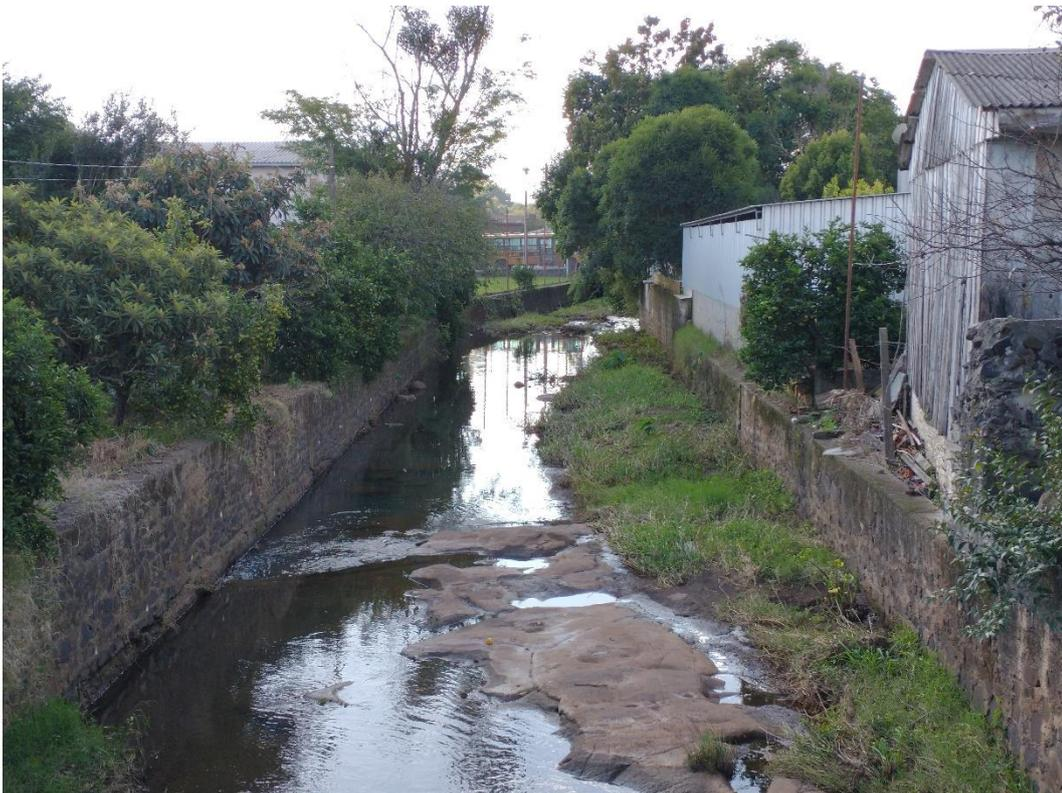
O efeito da antropização nesse segmento através do uso intensivo das margens é bastante claro através das figuras a seguir, que demonstram diversas construções diretamente sobre o muro de contenção do Arroio Lambari. Essa situação é frequente ao longo do segmento, e datam de décadas atrás.
