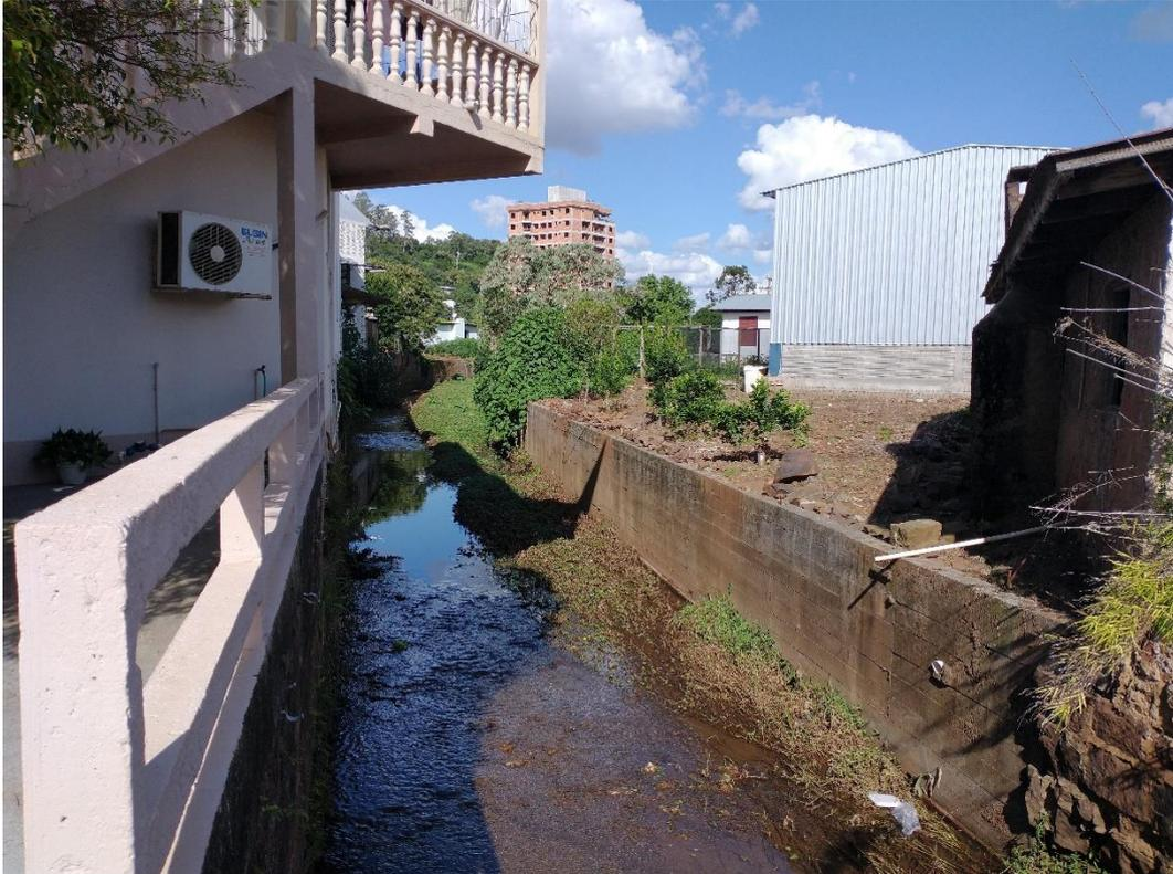
*Figura 34 – Edificações sobre o muro de contenção / canalização do Arroio Lambari*
