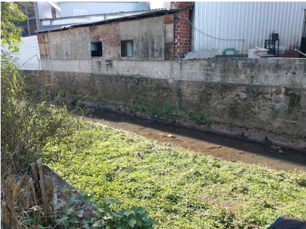
*Figura 33 – Edificação sobre o muro de contenção / canalização do Arroio Lambari*
